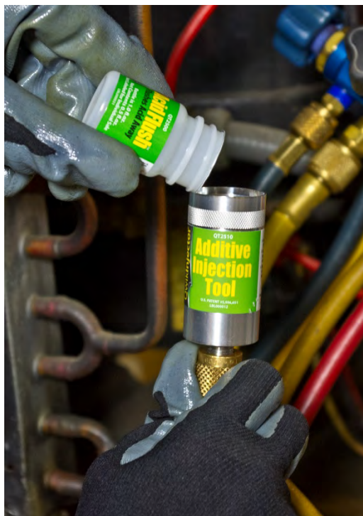
Figura C-13. QwikShot® se agrega al sistema con un QwikInjector®
