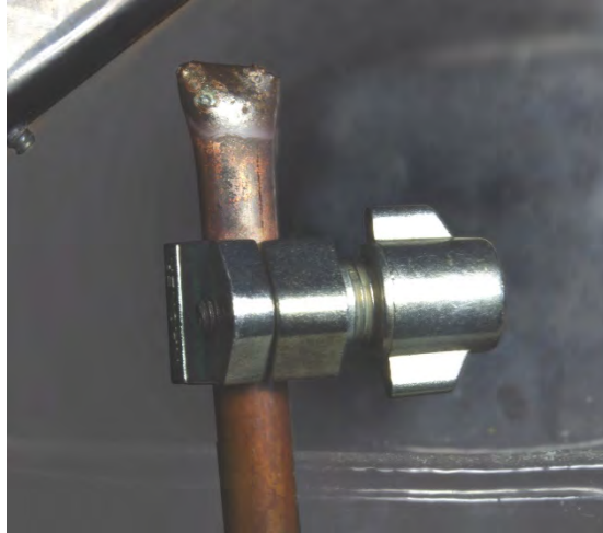
Figura I-3. Válvula de acceso de tipo perforadora en un aparato pequeño con refrigerante no inflamable
